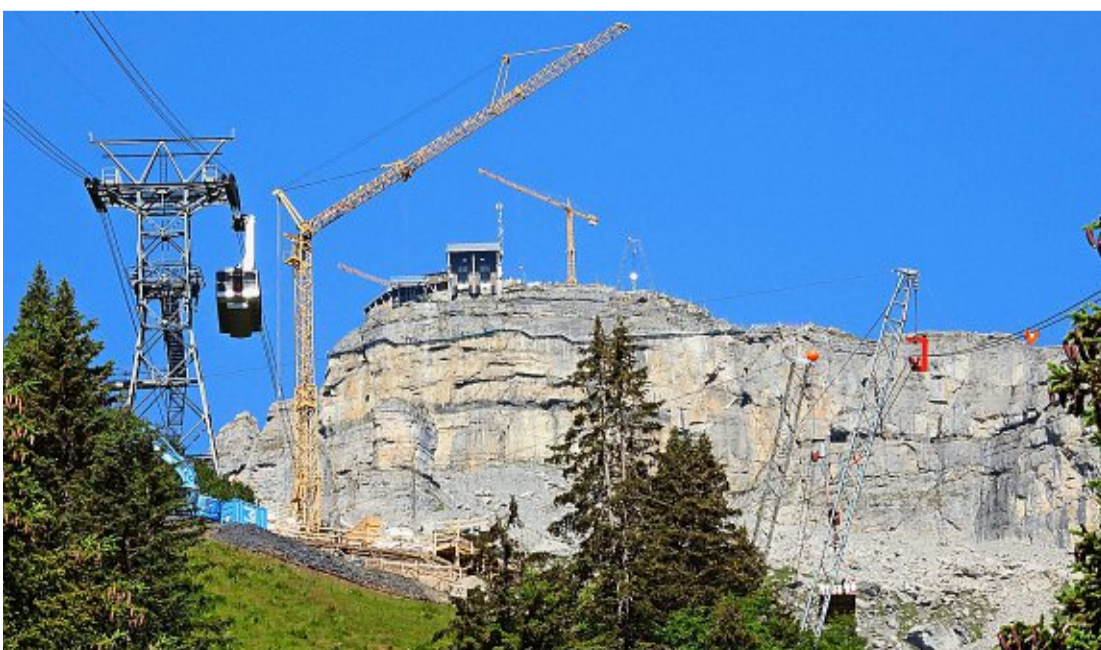
Kräne soweit das Auge reicht. Und mittendrin fährt die fast 60-jährige Luftseilbahn (links) im Fahrplankontakt.
