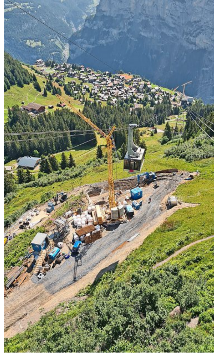
Hier neben der Suppenalp kommt eine Zwischenstütze zu stehen.
