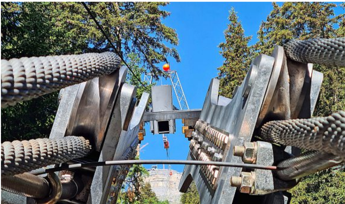
Diese massive Verankerung sichert quasi den Lebensnerv der Baustelle – die 8-Tonnen-Materialeilbahn.
