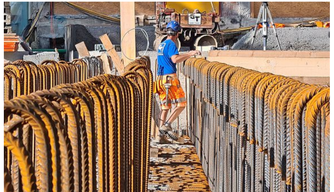
Bevor das Betonieren losgeht: Diese Armiereseisen gehören zum Fundament der neuen Station Mürren.
