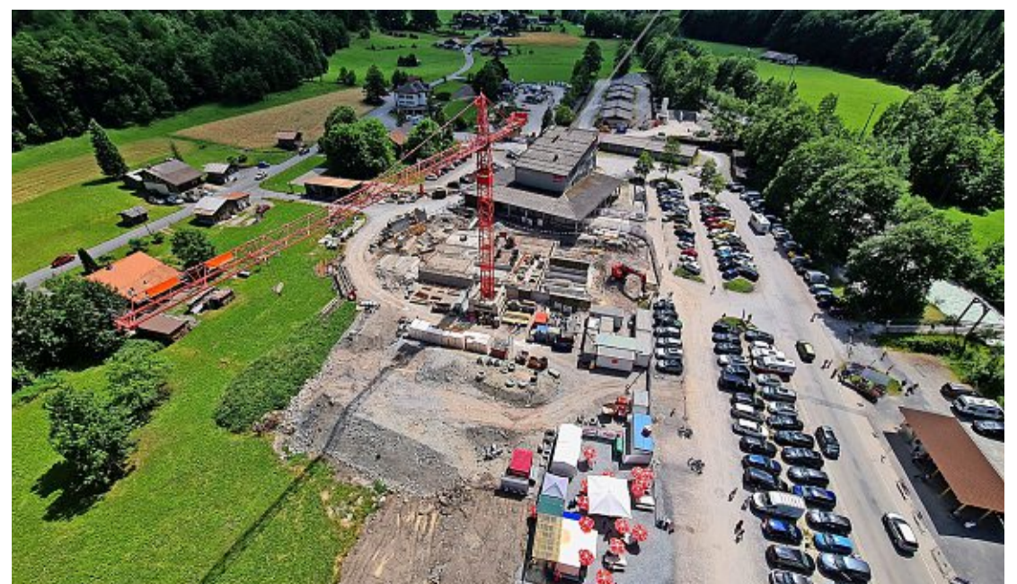
Hier entsteht die neue Talstation in Stechelberg. Darum herum läuft der Bahnbetrieb weiter.
