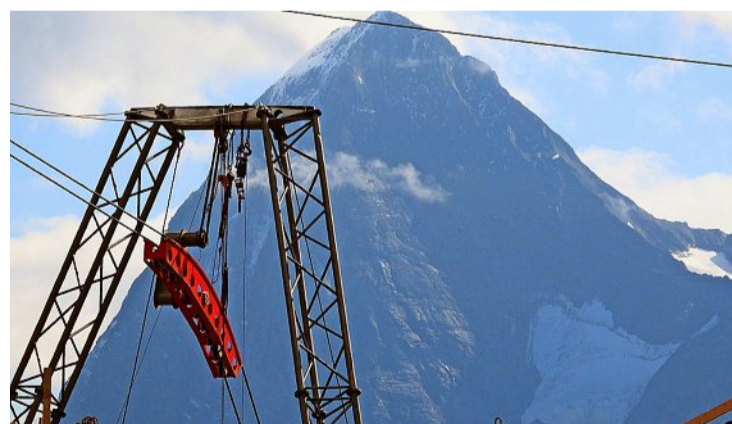
Nur schon dieser rote Doppel-Tragseilsattel wiegt allein 1,7 Tonnen.
