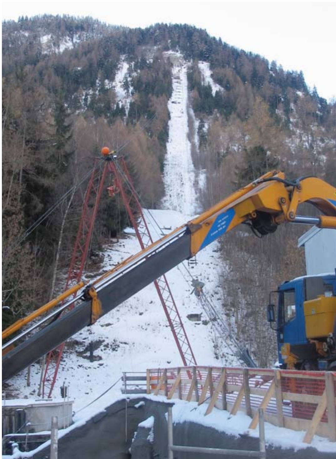
Le projet RenoEntremont inclut notamment la construction d'une nouvelle conduite forcée aérienne le long de cette tranchée, entre le château d'eau de Montatuay (en haut) et la centrale d'Orsières. LE NOUVELLISTE
