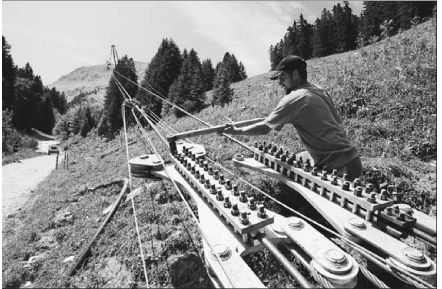
Mis en service mercredi, le blondin – ou téléphérique de chantier – permettra d'amener 8 tonnes de matériel au sommet en un peu moins de sept minutes. PHOTOS CLAUDE HAYMOZ
